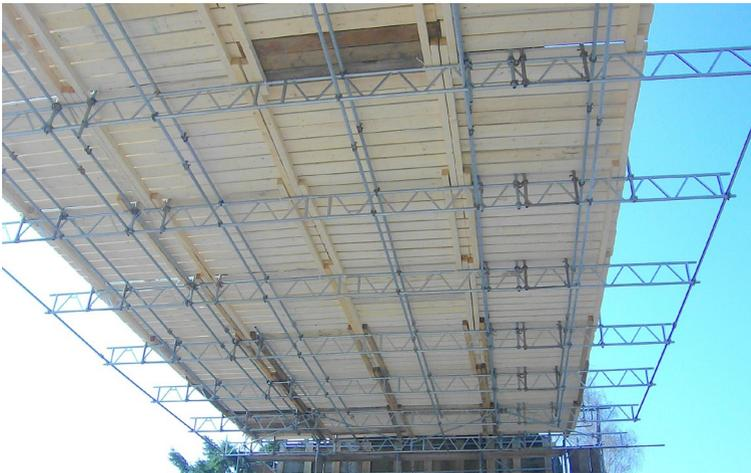
**Bild 31:** Untersicht eines Hängegerüsts mit Belagebene, Nebenträgern und Hauptträgern
