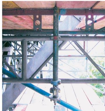
**Bild 19:** Unterer Anschlusspunkt einer Abhängung mit Gewindestäben an einen Gitterträger
