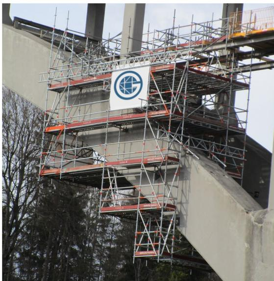
**Bild 33:** Hängegerüst an Bogenbrücke aus Stahlbeton
