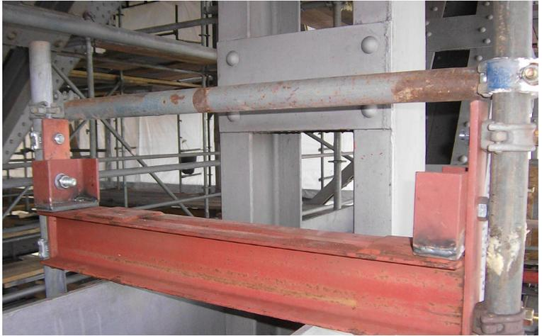
**Bild 36:** Aufhängepunkte an Stahlbauelementen mittels Halbkupplungen
