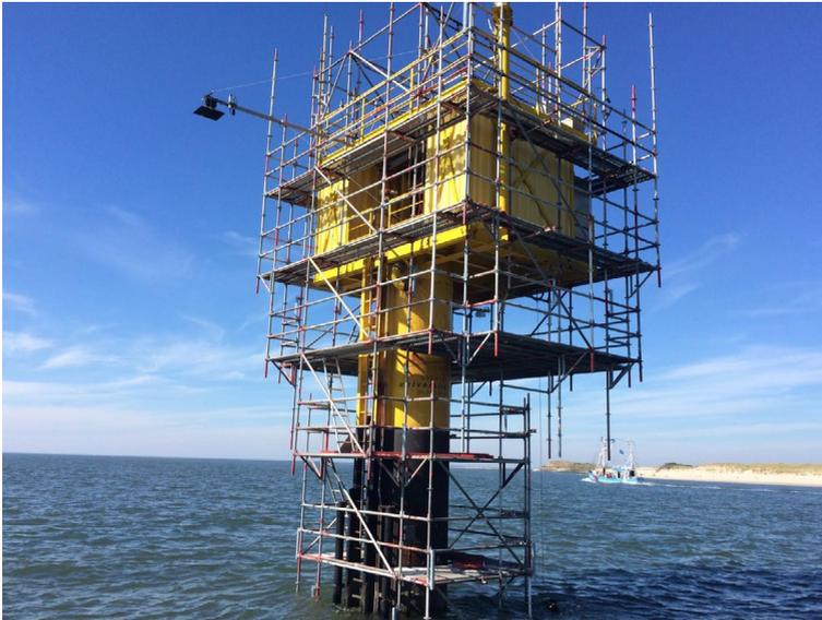
**Bild 35:** Hängegerüst an Pylon auf offener See
