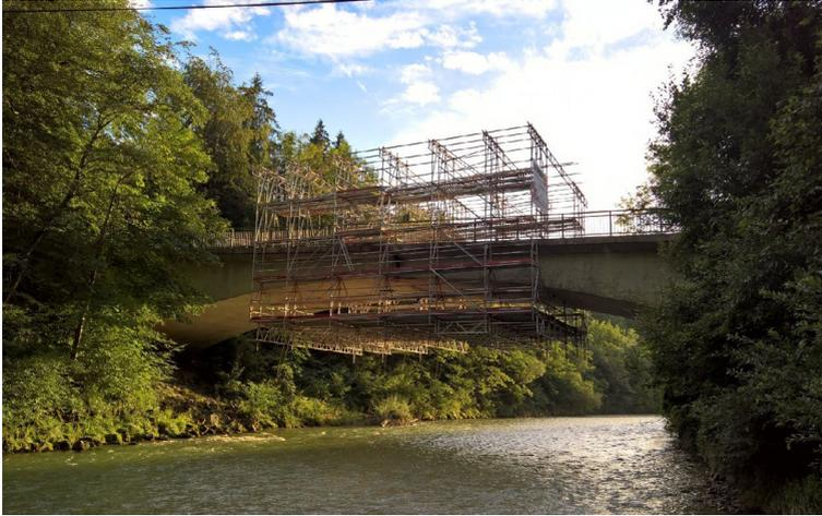
**Bild 34:** Hängegestüt an Bogenbrücke aus Stahlbeton
