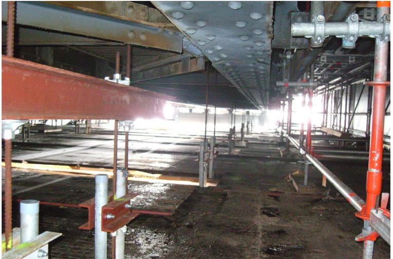
**Bild 37:** Aufhängepunkte an Stahlbauelementen mittels Gewindestählen
