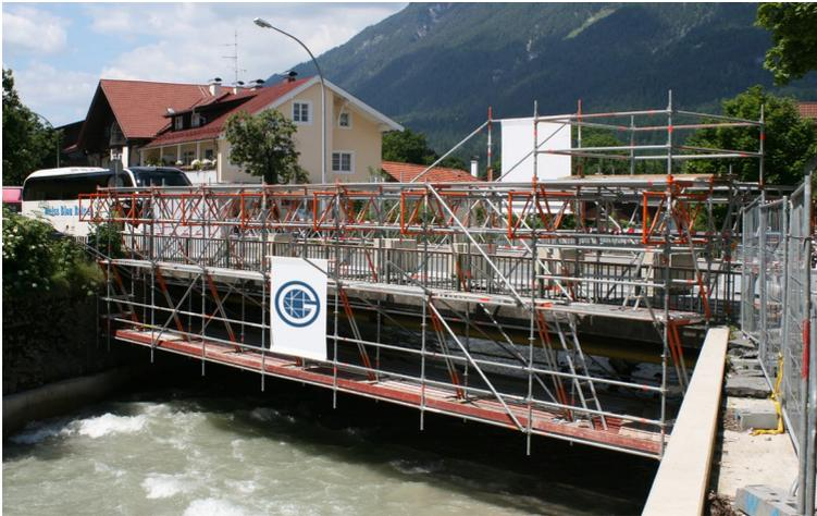
**Bild 30:** Hängegerüst an Kragarmen aus Gitterträgern mit Kontergewichten aus Stahlbeton
